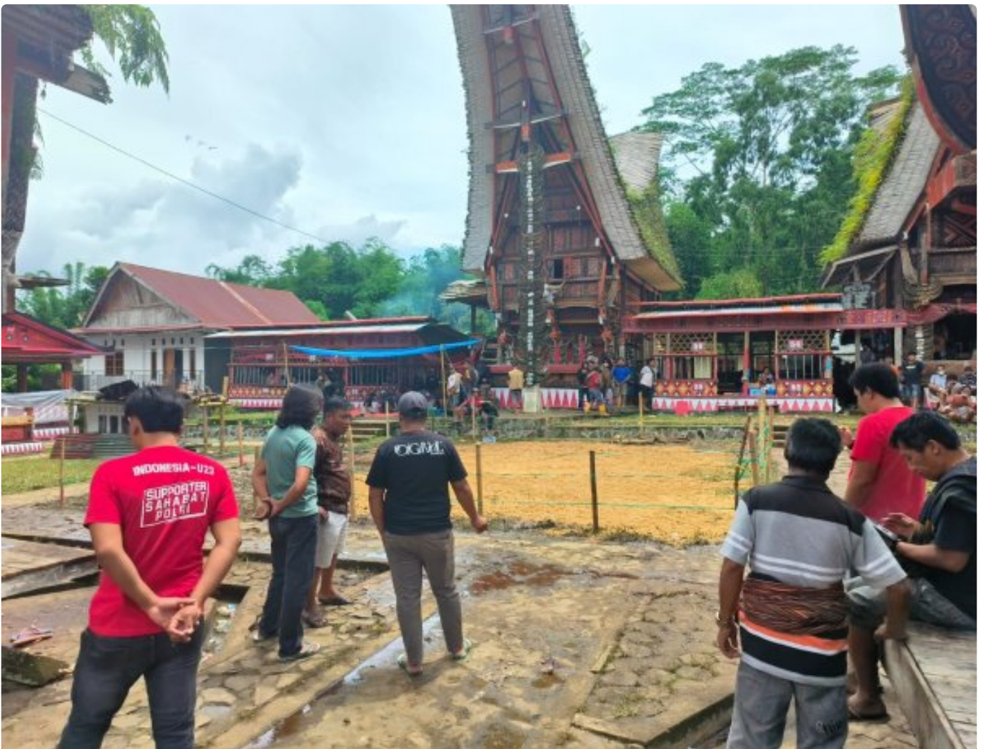
Pembongkaran Arena Judi Sabung Ayam di Sangalla
